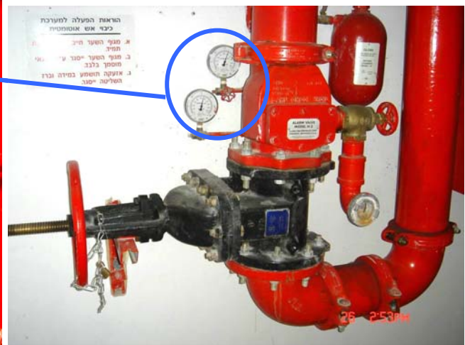
בתמונת למטה ניתן להבחין בלחצים הגבוהים, 170psi (מעל 11.5 בר).
